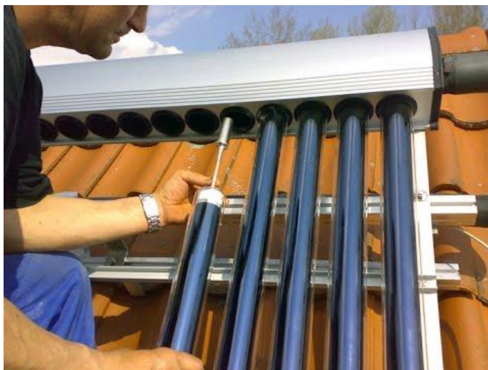
Figura 2.8 – Montagem de coletores à vácuo disposição no telhado Fonte: SUNRAIN
